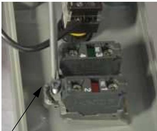
Tornillo del cuerpo del interruptor
